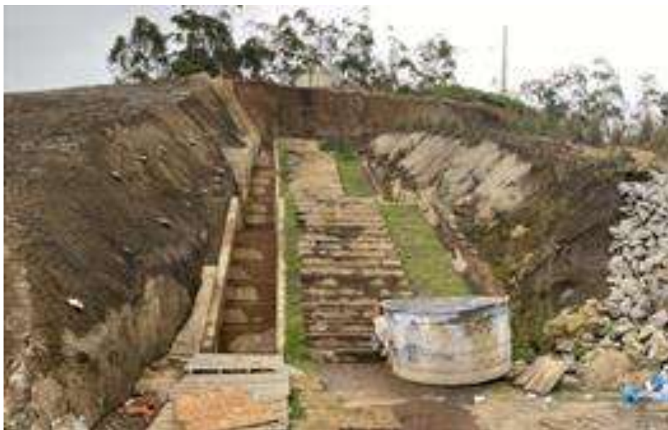
Figura 24 – Obras de contenção de drenagem
