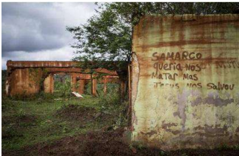
Figura 17 – Ruínas da Escola Municipal Bento Rodrigues
