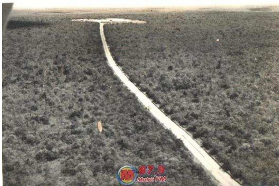
Figura 8: Estrada AR-1 concluída em Juína-MT
