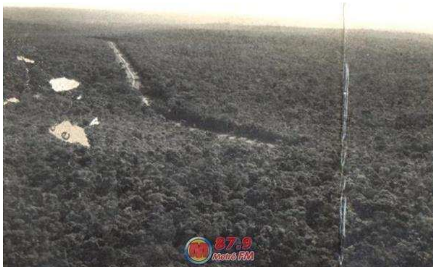
Figura 7: Visão aérea do processo de abertura da AR-1
